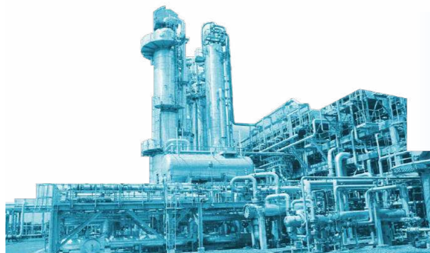
Dự án Nhà máy xử lý Khí Dinh Cố (8/2001 – 2/2002)
